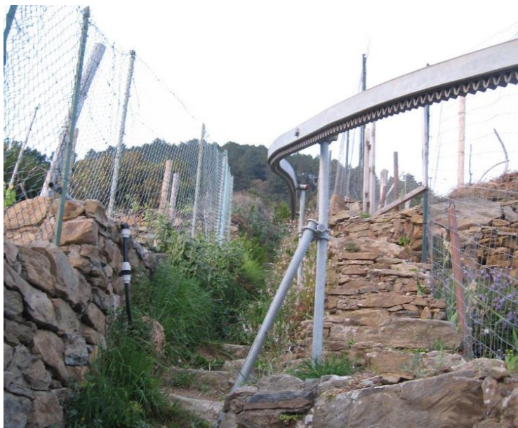
4. La part du feu : supports de petit train monorail dans les Cinque Terre (Italie) (photo P.-M. Tricaud, 2007)
